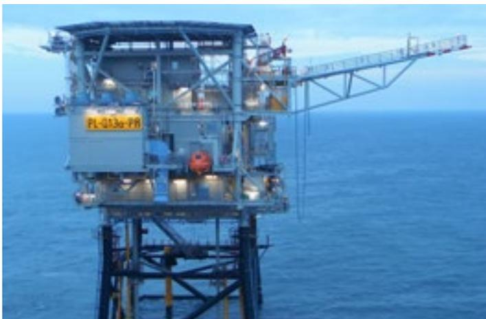
Una plataforma de petróleo y gas existente frente a la costa neerlandesa se está convirtiendo en la primera plataforma de hidrógeno en alta mar del mundo. La electricidad generada por las turbinas eólicas marinas se utilizará para convertir el agua de mar en agua desmineralizada y para alimentar un electrolizador de 1 MW que produce hidrógeno renovable.
