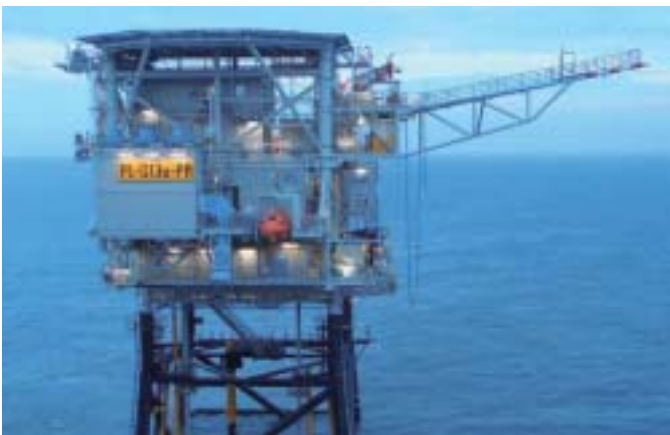
位于荷兰海岸的一座石油和天然气平台正被改造为世界上首个海上氢能平台。由海上风机产生的电力将用于淡化海水，同时为一台生产清洁氢能的1兆瓦电解槽提供动力。
