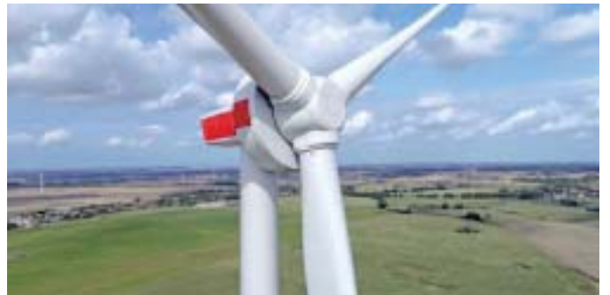
HYGRO专注于生产、运输和配送直接利用风能制成的氢气。该公司目前正在北荷兰省建造一台集成了电解槽的4兆瓦的风机，旨在最大限度地发挥风力发电、氢能生产、管网及储存技术之间的协同增效作用。这个概念优化了风能到氢能的转化过程，氢能的运输成本比电力大幅降低，并大幅减小了空间规划的影响。
